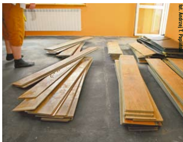
Panele podłogowe z zalanych pomieszczeń trzeba wyrzucić
